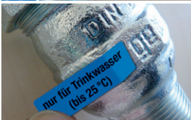
Bild 5: Zum Schluss unbedingt den kleinen blauen Aufkleber mit der Aufschrift „nur für Trinkwasser (bis 25°C)“ auf die Verschraubung kleben. So können Sie noch nach Jahren beweisen, dass Sie rechtzeitig das richtige Material verbaut haben.
