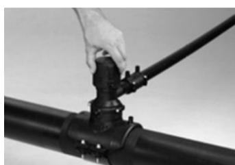
Прорезаем трубу с помощью специального прорезного устройства. (ТОЛЬКО ДЛЯ СЕДЕЛКИ С ФРЕЗОЙ).
