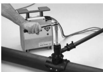
Устанавливаем наконечники, включаем аппарат для сварки, считываем штрих-код с фитинга, ждем окончания операции.
