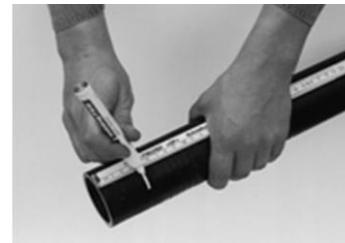
Обезжириваем поверхность прилегания фитинга к трубе.
